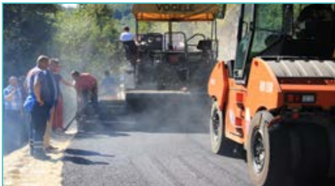
Asfaltiranje puta Čava - Radoč
