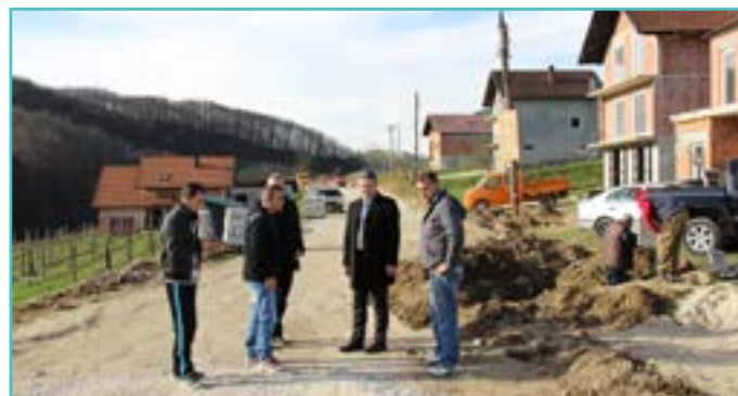
Asfaltiranje puta Bezi - Bajrektarevići polje
