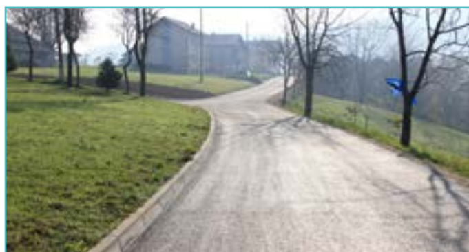
Asfaltiranje puta Mulalići u MZ Mrazovac
