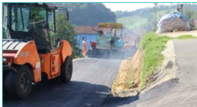
Asfaltiranje puta Lipa - Jušići
